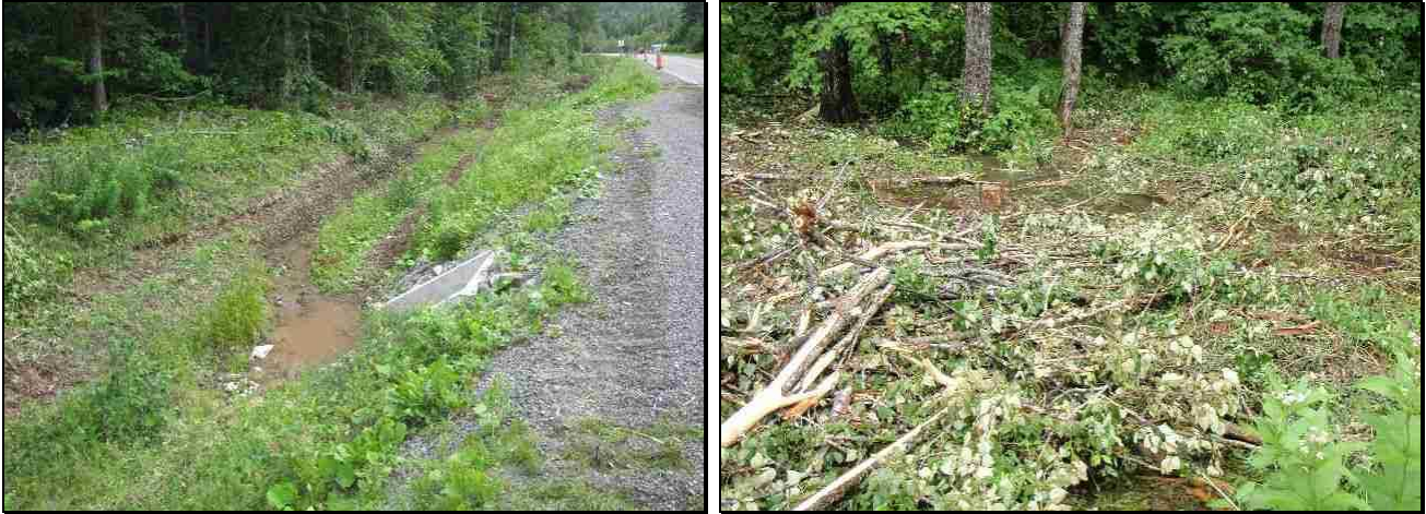
Figure 17: Passage de la machinerie dans le lit du cours d'eau permanent (station 80) et dans le lit du cours d'eau intermittent (station 51)
