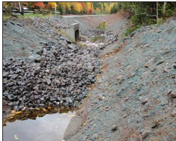
Sortie du ponceau de la station 119
