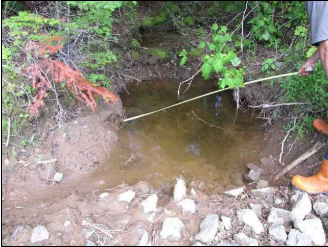
Station 30, km 53,0; Entrée du ponceau
