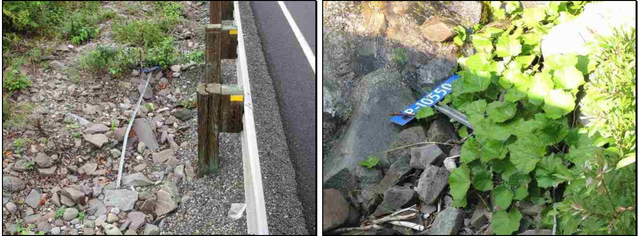
Figure 33: Panneaux de signalisation abandonnés au sol; Stations 94 et 83
