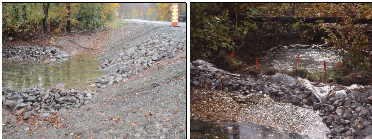
Km 18,7 : Ouvrage terminé à la sortie du ponceau selon le MTQ
