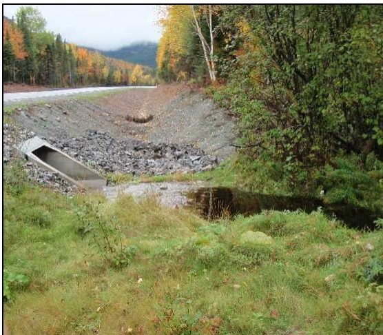
Entrée du ponceau de la station 119; km 49,8
