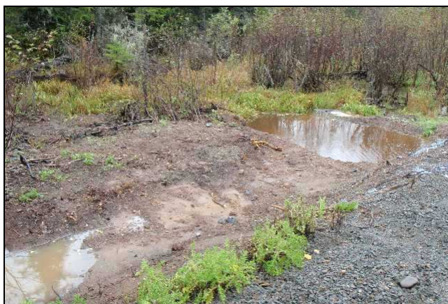
Km 67,5: Reconstruction de la canalisation des fossés, 1 er octobre 2010
