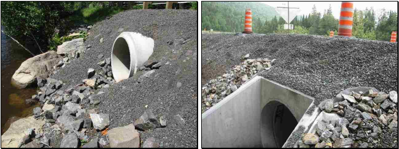
Figure 21: Gravier aménagé des ponceaux s'écoulant vers la rivière; Stations 31 et 101
