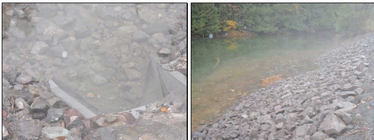
Km 18,7 : Entrée du ponceau
