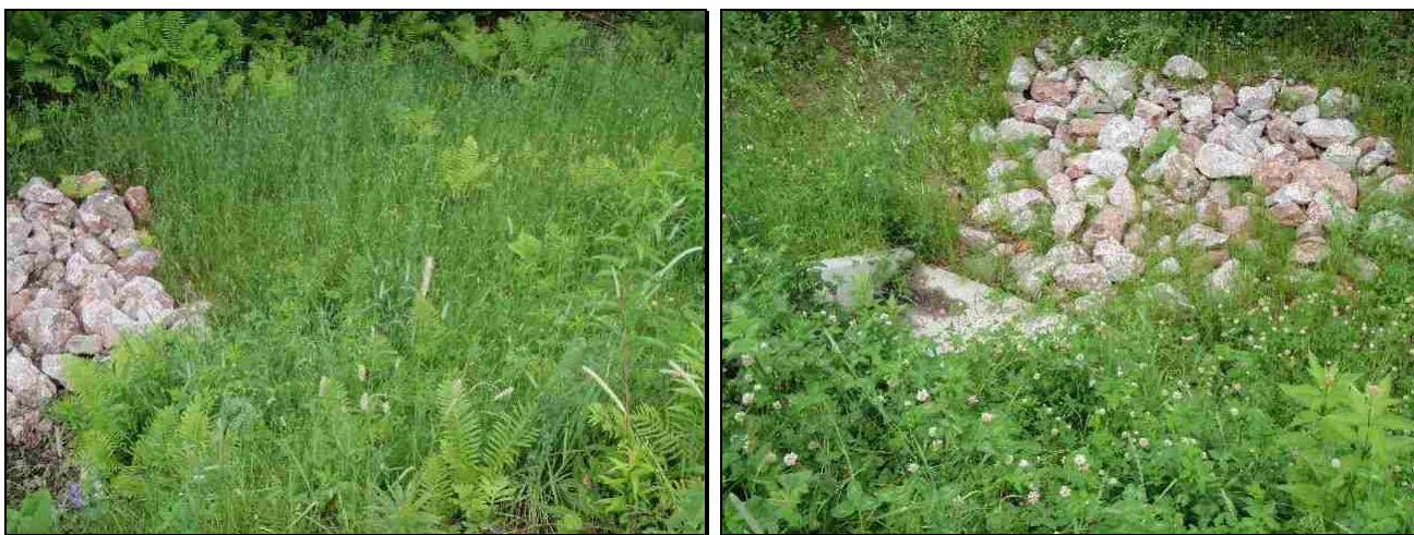
Figure 13: Stabilisations exemplaires à la sortie du ponceau; Station 53 et 36
