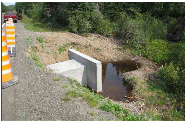
Km 67,5: allongement des extrémités du ponceau, juillet 2010
