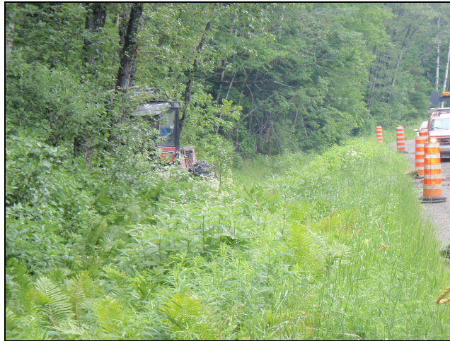
La machinerie est stationnée dans le ruisseau.
