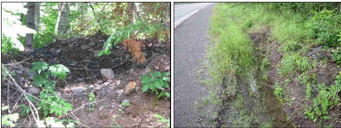
Figure 12: Exemples d'emplacements où le matériel meuble fut excavé et renvoyé sur le talus supérieur; Stations 30 et 98
