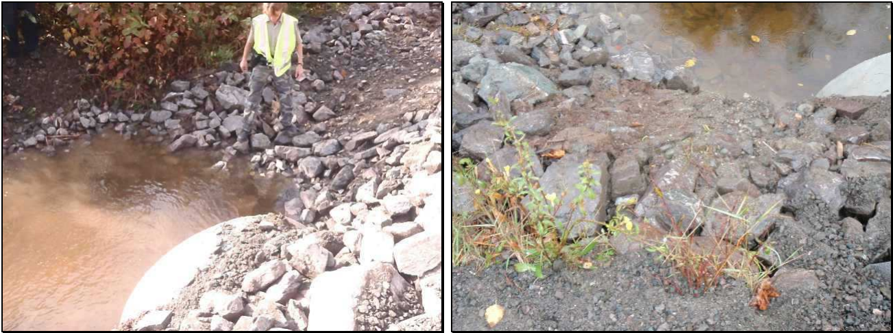
Station 67, km 19,6 : Allongement du ponceau
