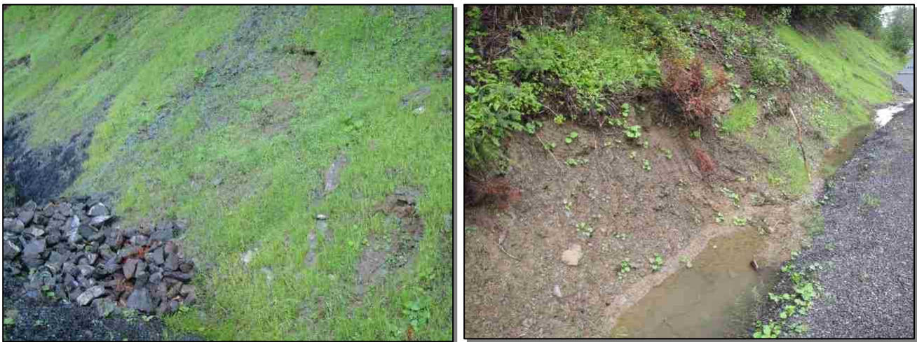
Figure 27: Hydro-ensemencement réalisé en 2009, une technique aux résultats mitigés; Station 14
