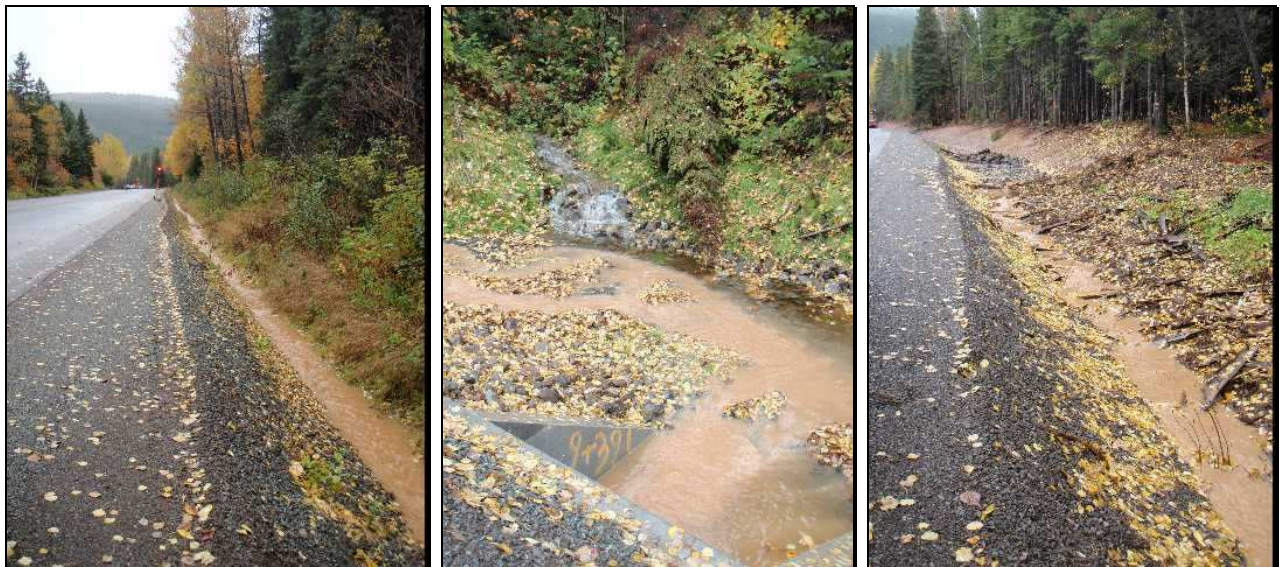
Station 32, km 54,2 : Photographies prises le 1 er octobre 2010; travaux en cours
